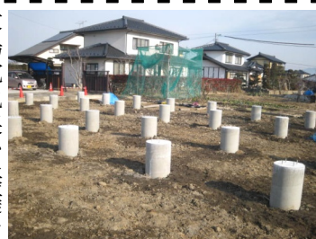
太陽電池架台基礎を12月に施工しました。
